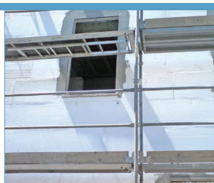
Fachada sem elementos arquitectónicos relevantes, revestida por sistema de isolamento térmico exterior tipo “cappotto”.
